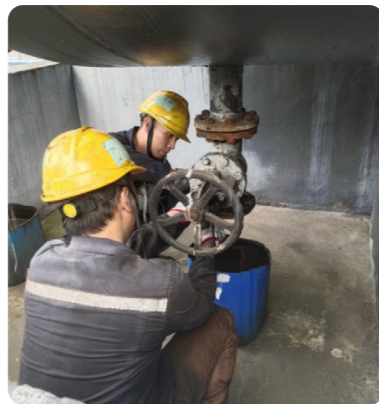
抢修组安装密封盲板
